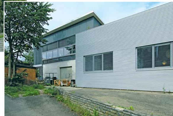
Ein paar Schritte hofeinwärts, und man sieht mehr: die Halle mit Pulldach und großzügig verglastem Obergeschoss.
