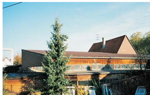
Kein Bild aus besseren Tagen: die alte Halle, noch mit nach Norden angehobenem Pulldach, und das mit Faserzementplatten verkleidete Fachwerkhaus. Andreas Eberhard
