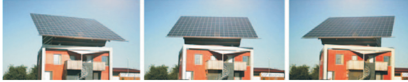
Wohnhaus mit nachgeführter PV-Anlage (Foto: Solep)
