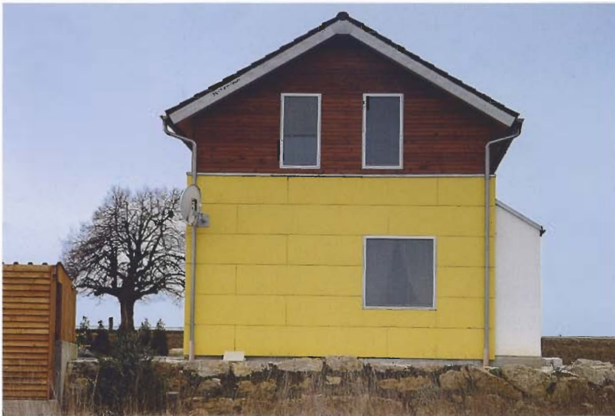
Die Ostansicht zeigt die klare Formgebung. Die Trennung von Holz- und Massivbau wurde vom Architekten bewusst auffällig ausgeführt.
